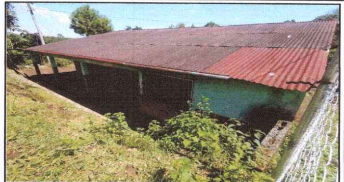
Foto 2: SUSTITUCION DE LAMINA POR DETERIORO
