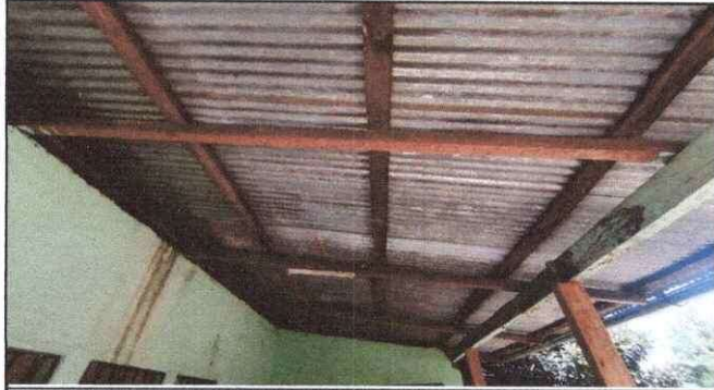
Foto1: SUSTITUCION DE ESTRUCTURA DE MADERA POR DETERIORO
