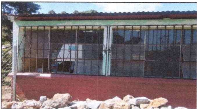
Foto 3: SUSTITUCION DE VIDRIOS
