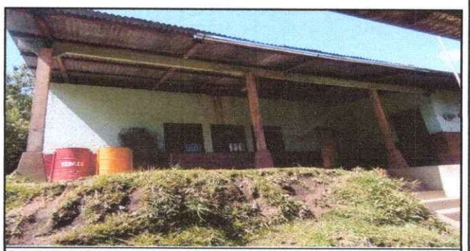
Foto 6: SUSTITUCION DE SOPORTE O PESCANTE DE METAL PARA CANAL
