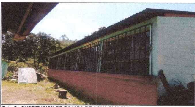
Foto 5: SUSTITUCION DE BAJADA DE AGUA PLUVIAL
