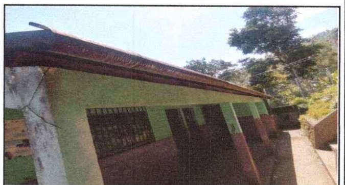
Foto 4: SUSTITUCION DE CANAL DE METAL
